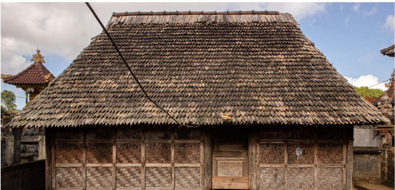
Gambar 4. Penggunaan Material Bambu pada atap dan dinding Gedeg
