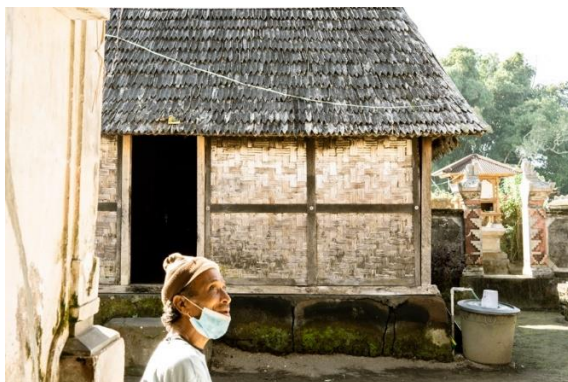
Hasil penelitian menunjukkan bahwa Bale Paon di Desa Bayung Gede dapat diklasifikasikan berdasarkan tingkat pelestarian material vernakularnya. Klasifikasi Tipe A (warna kuning ) merujuk pada bangunan yang masih mempertahankan struktur asli dengan penggunaan material alami seperti kayu dan bambu dalam keseluruhan elemen bangunan. Berdasarkan observasi lapangan, sekitar 30% dari total rumah di desa ini masih tergolong dalam kategori ini, di mana struktur, dimensi, dan material bangunan tidak mengalami perubahan signifikan sejak pertama kali dibangun.
