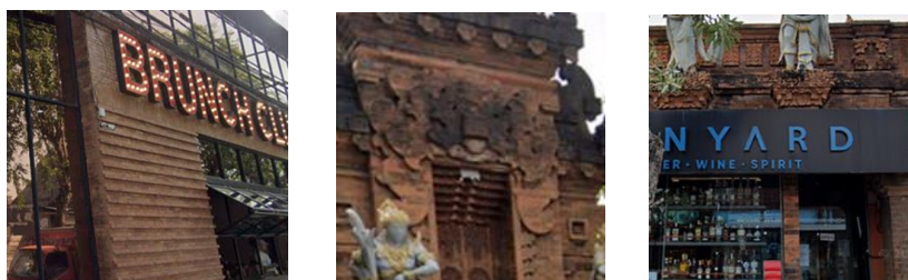
Gambar 11: Penggunaan Bata Merah Pada Fasad Bangunan
