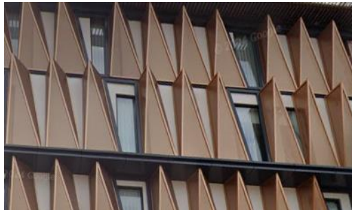
Gambar 9: Penggunaan HPL ( high pressure laminate ) Pada Fasad Bangunan
