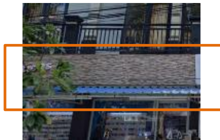
Gambar 6: Penggunaan Keramik Pada Fasad Bangunan
