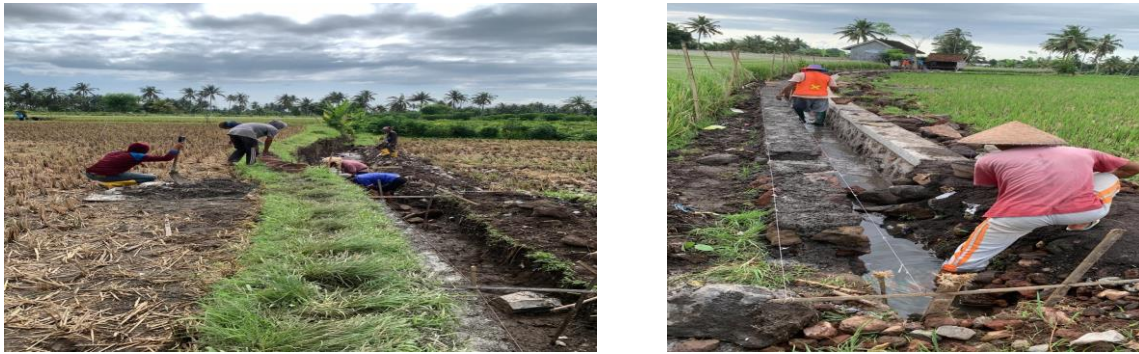
Gambar 1. Pekerjaan Galian Saluran Tersier
