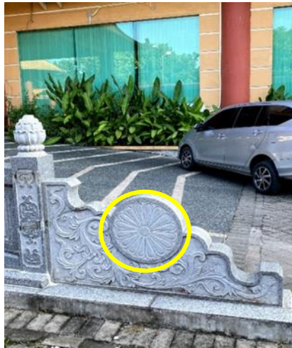
Gambar 10. Tembok Pembatas Jalan
