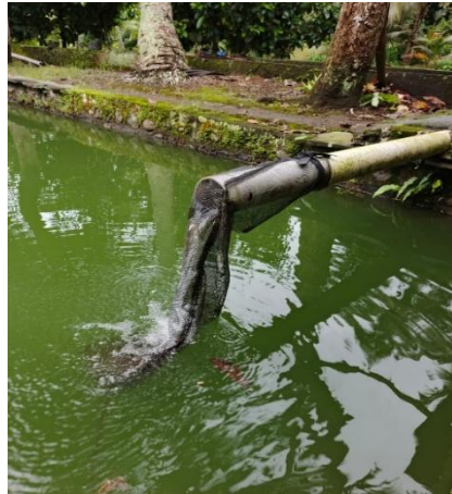
Gambar 5. Pemasangan jaring ke pipa masuknya air (Sumber : dokumentasi pribadi 2025)
